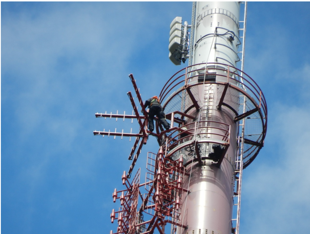
Montage der Antennen am Sendemast Chrischona
